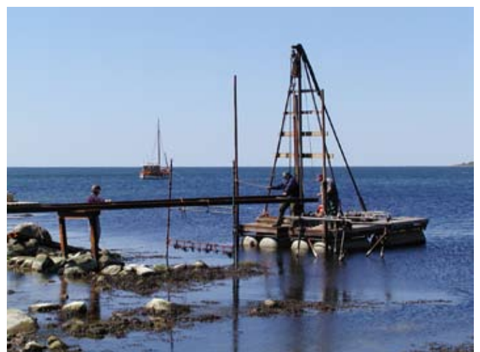
2004 byts rören ut mot järnvägsräls. Den gjordes också högre för att klara stormar bättre.
