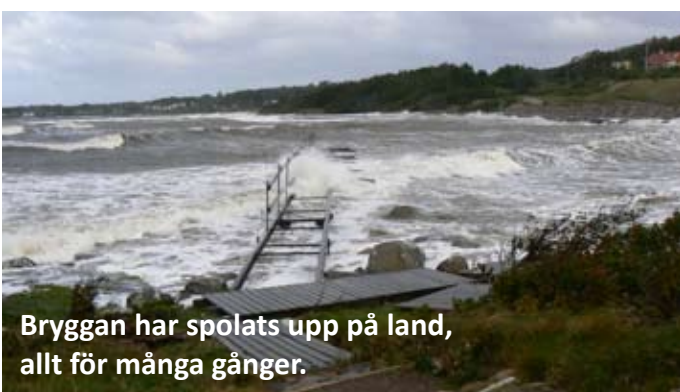
2004 byts rören ut mot järnvägsräls. Den gjordes också högre för att klara stormar bättre.
