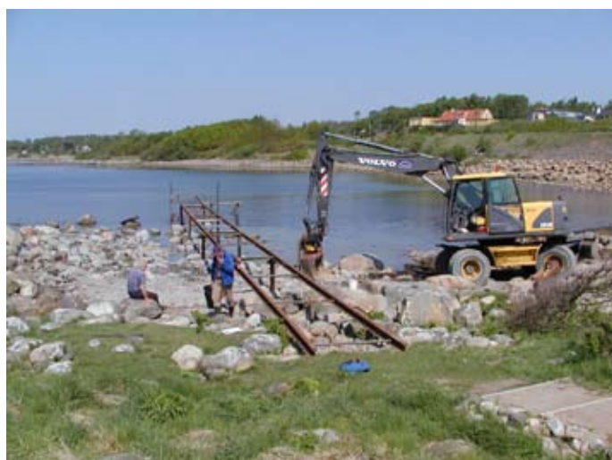
2004 byts rören ut mot järnvägsräls. Den gjordes också högre för att klara stormar bättre.
