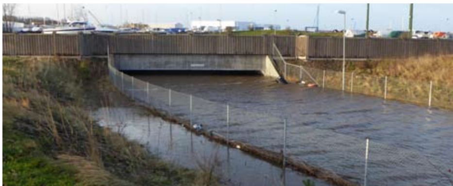
Gorms höga vattenstånd fick stora konsekvenser bland annat fylldes Via Marina tunneln.
