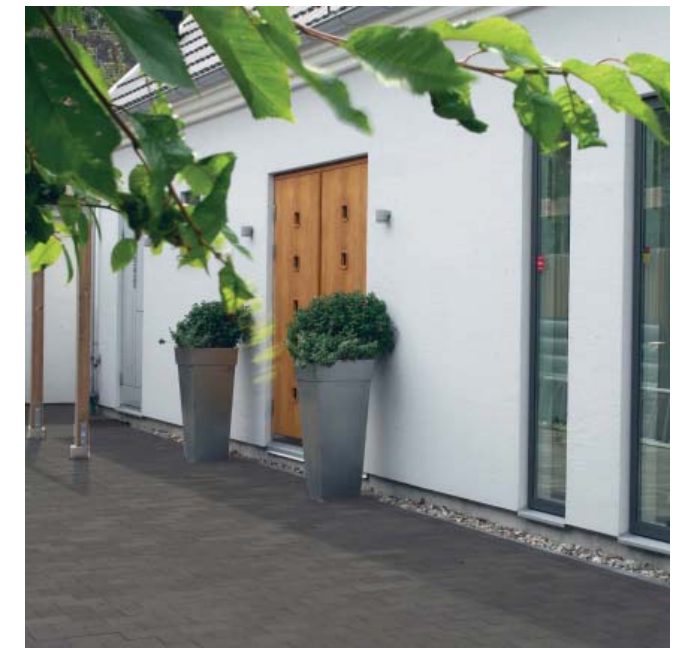
Föreslagen markbeläggning, betongmarksten Scala i färgen Antracit. Två storlekar av fyrkantiga stenar.
